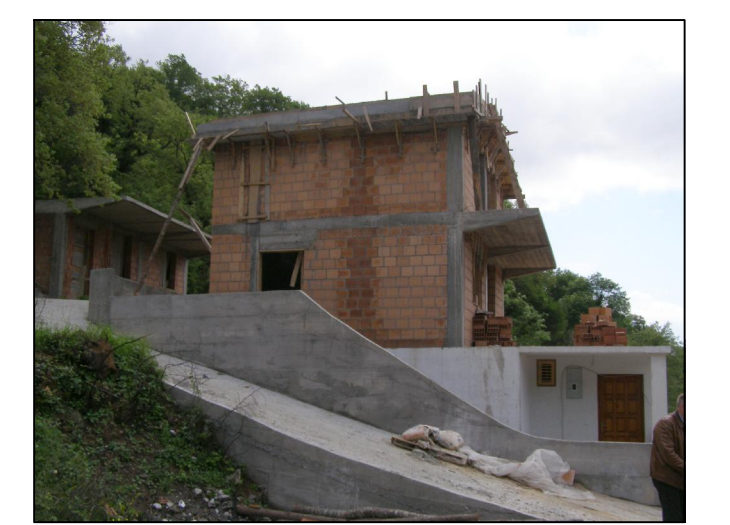
5. OBJEKAT PREDVIĐEN ZA RUŠENJE
