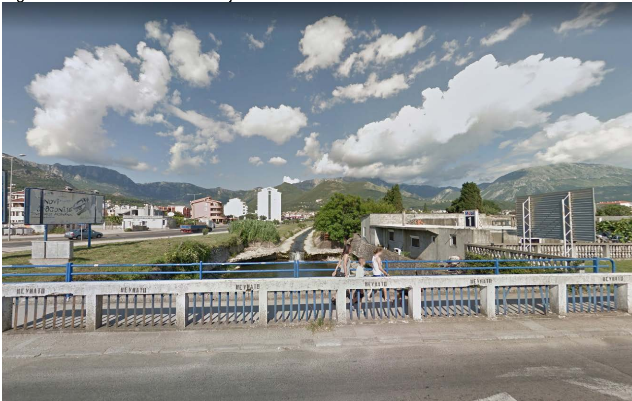
Slika 2: Korito rijeke Željeznice – pogled sa mosta u ulici Jovana Tomaševića
