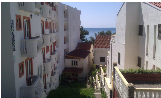
Slika: Novogradnja u Sutomoru
