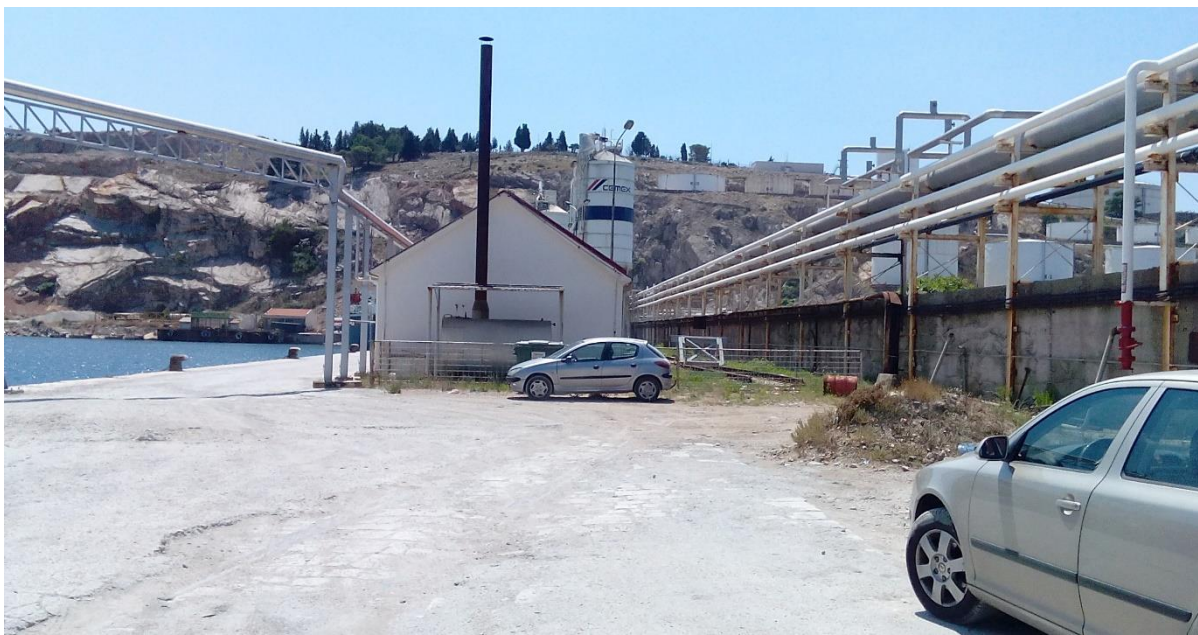
Sl.7 Predmetna lokacija (7.5) za izgradnju silosa za cement
