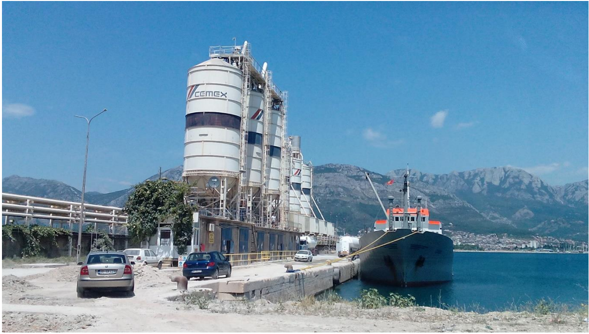
Sl.6 Pogled na glavni lukobran sa pristupnog puta
