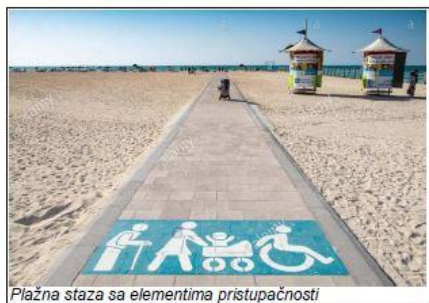
Plažna staza sa elementima pristupačnosti
